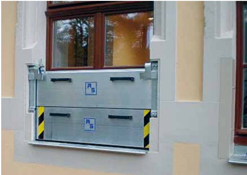
Hochwassersicherung von Fensteröffnungen
