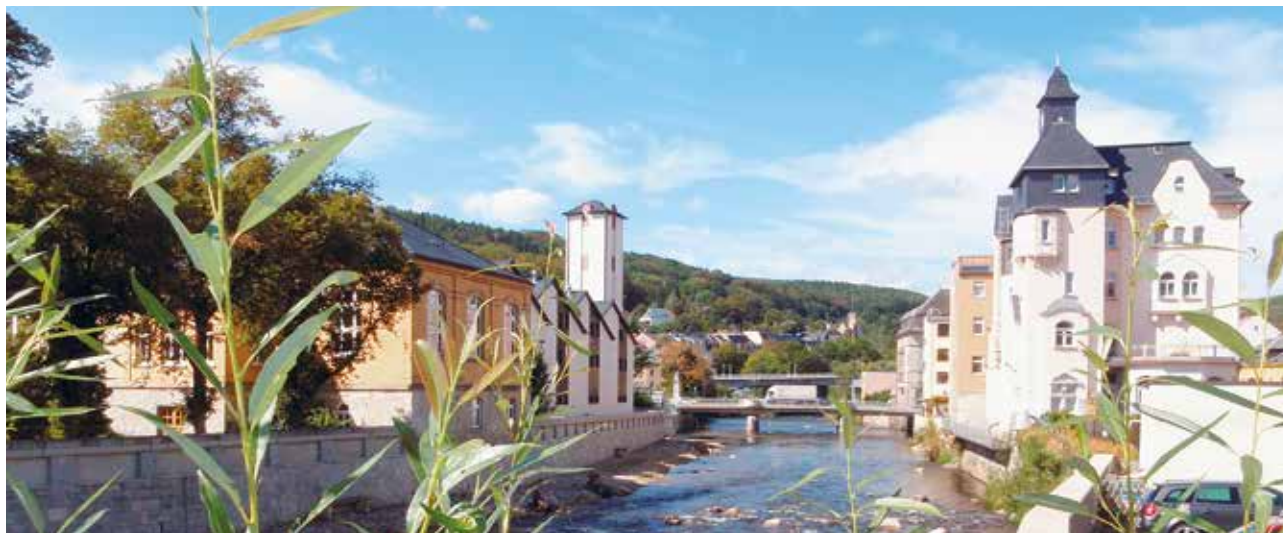
Hochwasserschutzmaßnahme in Aue
