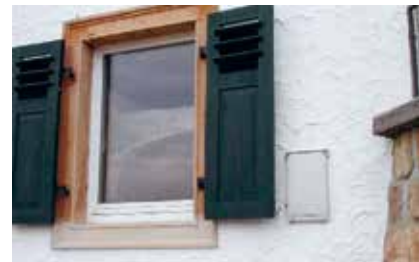
Hochgesetzter Elektroanschluss
