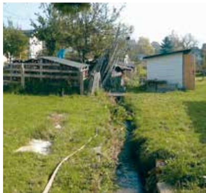
Negativbeispiel: völlig verbautes Gewässer
