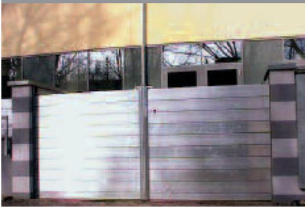
Umlaufender Hochwasserschutz mit teilmobilen Schutzelementen
